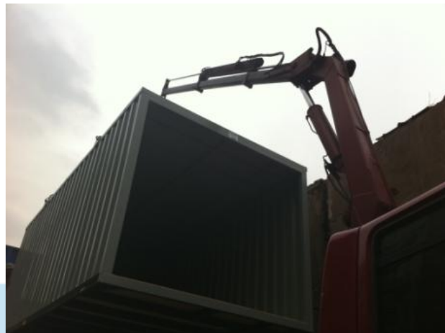
2 MONTAJE DE CONTENEDORES
