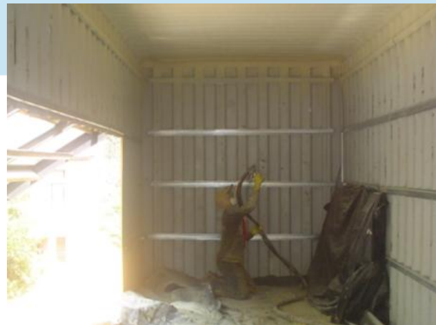
3 INSTALACION DE AISLANTE
