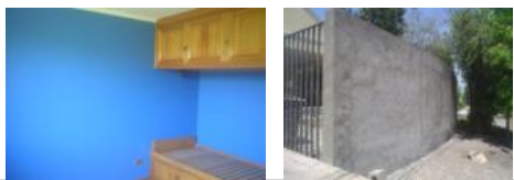
2 INSTALACIÓN DE CERÁMICAS
